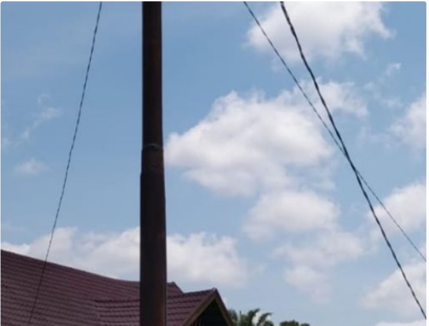
Pemasangan lampu PJU bantuan CSR Bank Riau Kepri di Kuansing
